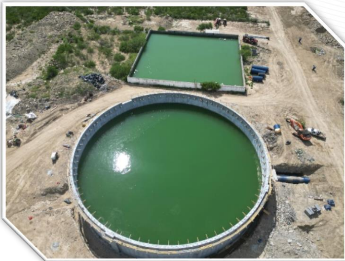
Tanque de sumergencia
